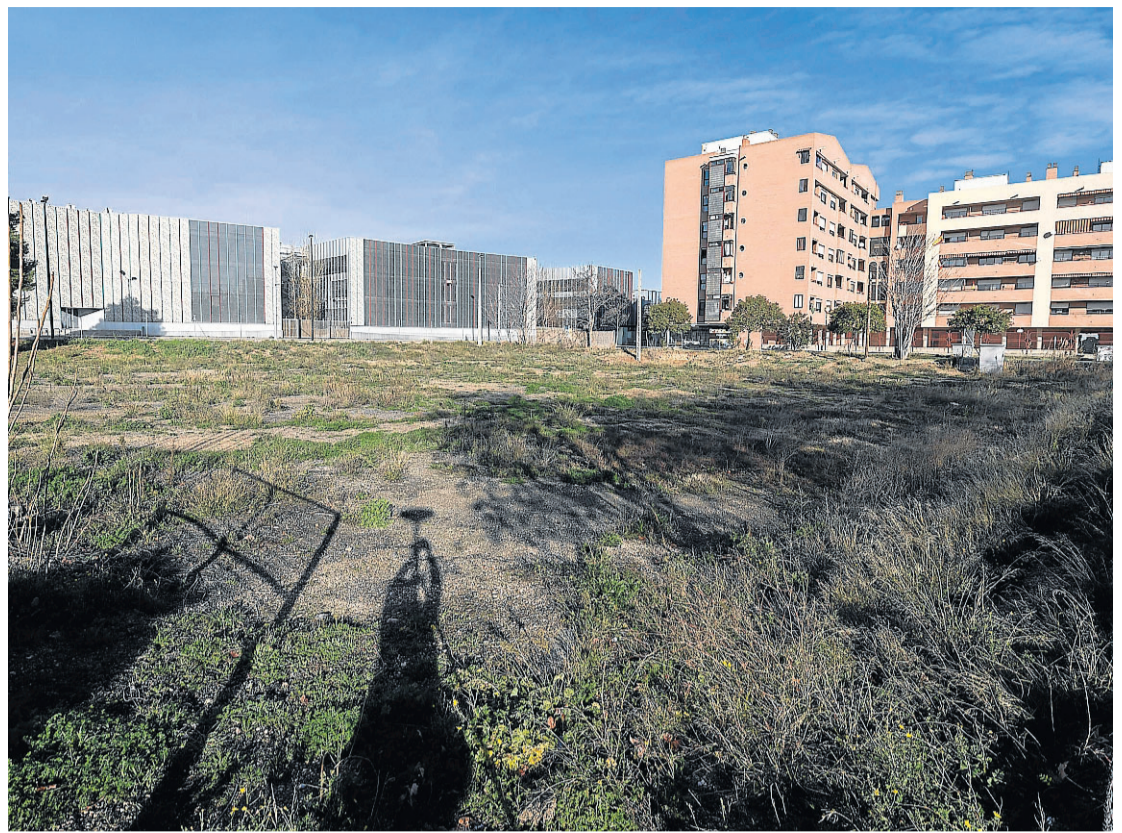
El solar del Actur junto a Cartv y la escuela de artes albergará 219 pisos de alquiler asequible. OLIVER DUCH
